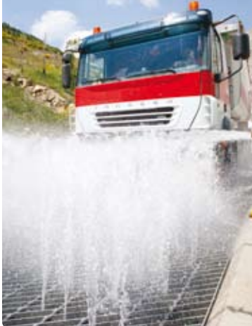
Sistema automatico di lavaggio degli pneumatici dei mezzi pesanti in uscita dall'area di cantiere
