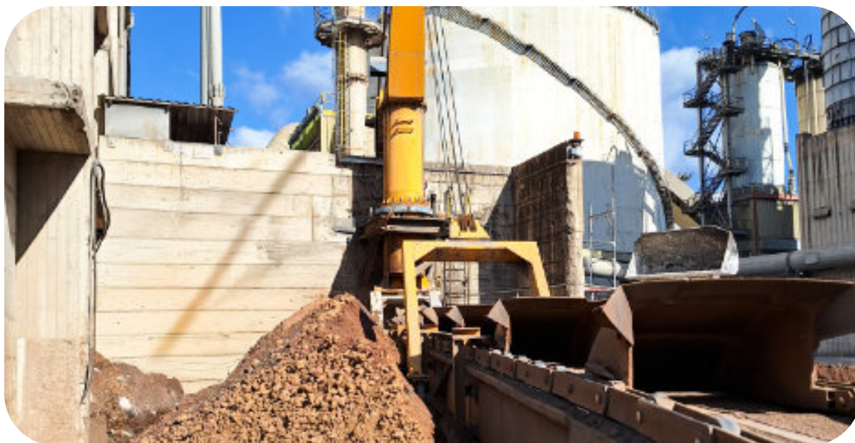
Alimentazione tramoggia della pozzolana
