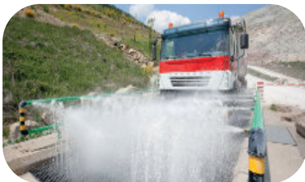
Lavaggio degli pneumatici dei camion all'uscita dalla miniera
